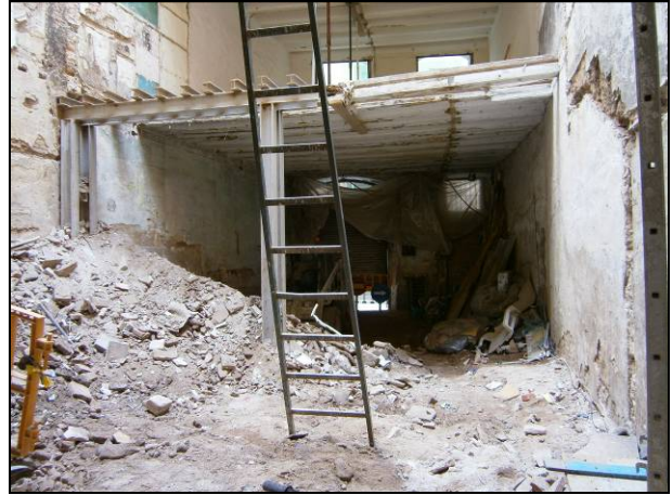
FOTO 2. Vista general de l'interior de la planta baixa en iniciar la intervenció de control
