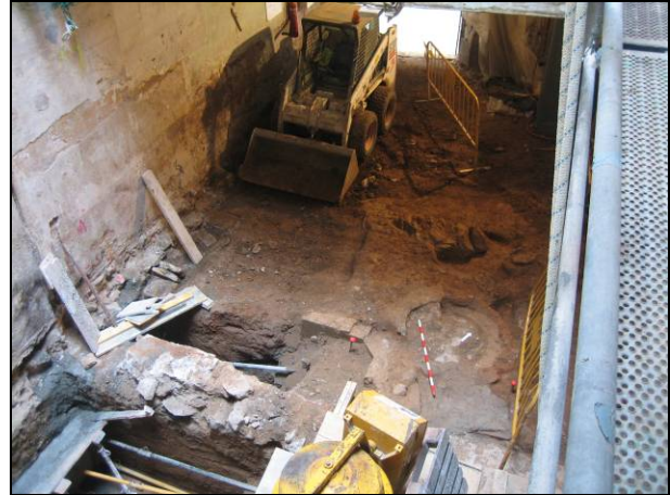
FOTO 26. Vista general de la planta baixa amb les estructures documentades durant el tram final del control
