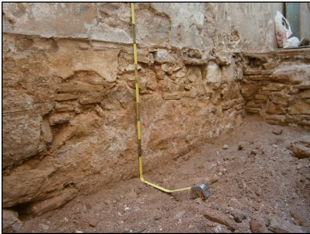
FOTO 11. Detall de la mitgera entre el número 64 i el número 66. Podem apreciar-hi una llinda en forma d'arc de mig punt (a l'esquerra). Planta baixa
