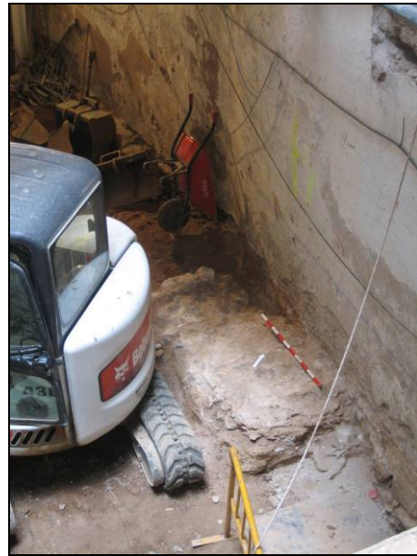
FOTO 22. Estructura massissa UE 121. Planta baixa
