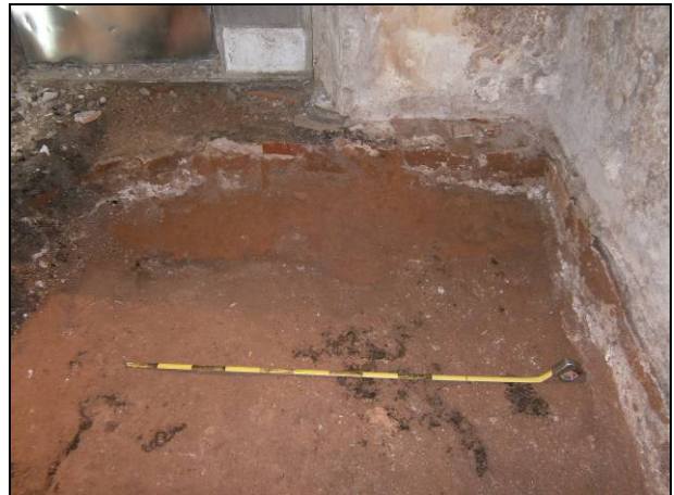
FOTO 4. Aflorament dels llims del substrat geològic, al fons, a l'extrem S del soterrani
