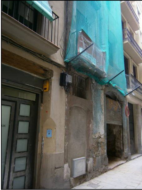
FOTO 1. Vista de l'entrada de l'immoble al carrer de Sant Pere Mitjà, 64
