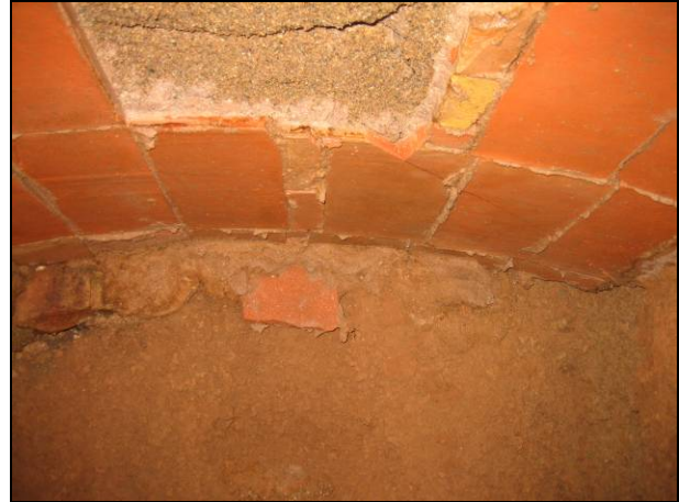
FOTO 18. Volta catalana de maó i ciment que cobria el pou UE 134
