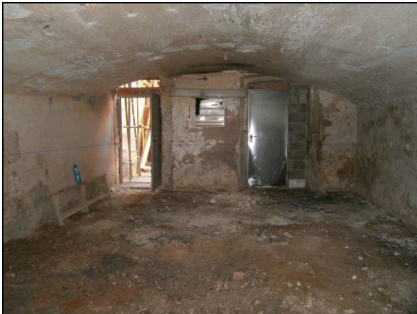
FOTO 3. Vista del soterrani en iniciar la intervenció de control
