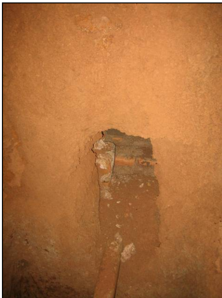
FOTO 19. Accés que comunicava el soterrani de la finca amb l'interior del pou UE 134. Aparegué tapiat i amb una canalització de fibrociment que funcionava com a desguàs del soterrani.
